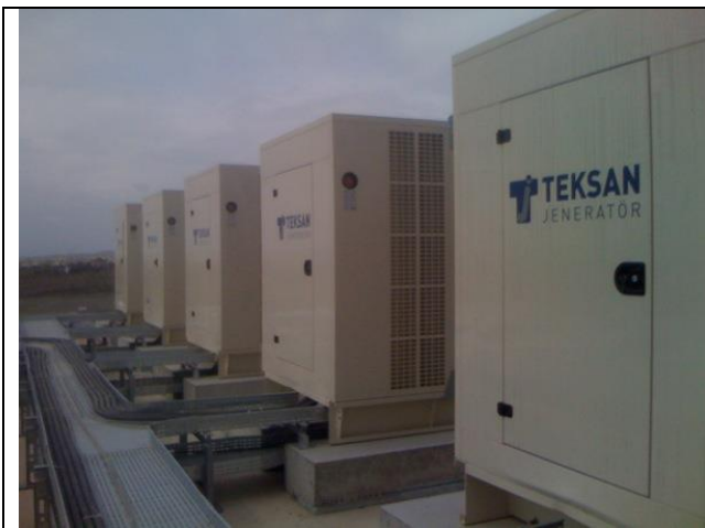
2x700 KVA + 3x500 KVA Synchronised Generators
